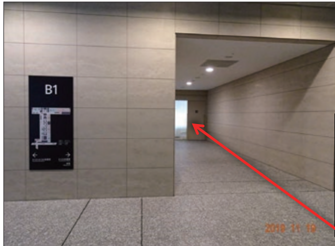
図7. 参議院会館、地下1階の奥まった喫煙室
