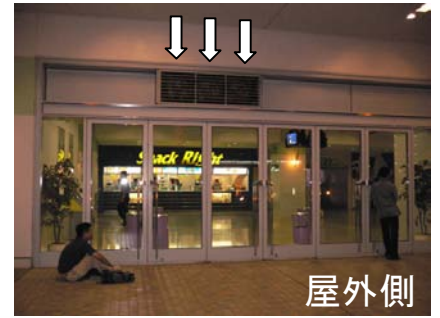
各喫煙コーナーには3台の排気装置
