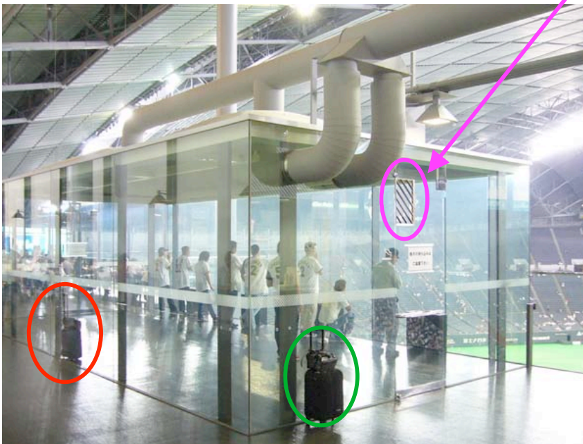
排気口が2カ所。 合計排気風量12.6m 3 /min。 屋外へ排気
